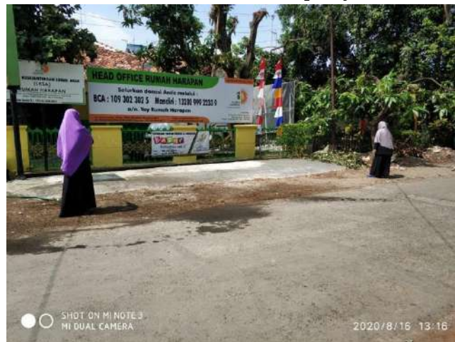
Gambar 1. Gedung Yayasan Rumah Harapan Karawang Head Office
