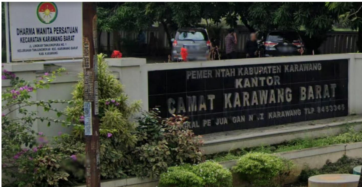
Gambar 1. Kantor kecamatan Karawang barat
